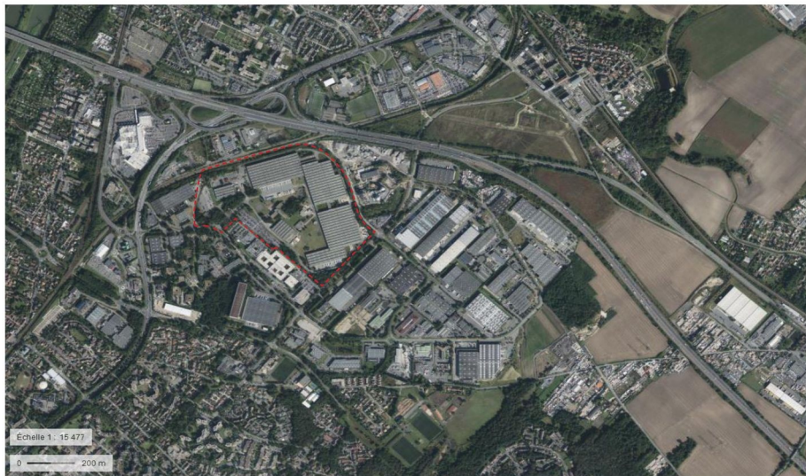
Figure 3: Vue aérienne du site et de son environnement proche. Source : MRAe à partir d'une vue Géoportail.
